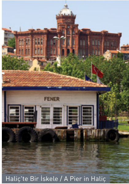
Haliç'te Bir İskele / A Pier in Haliç
